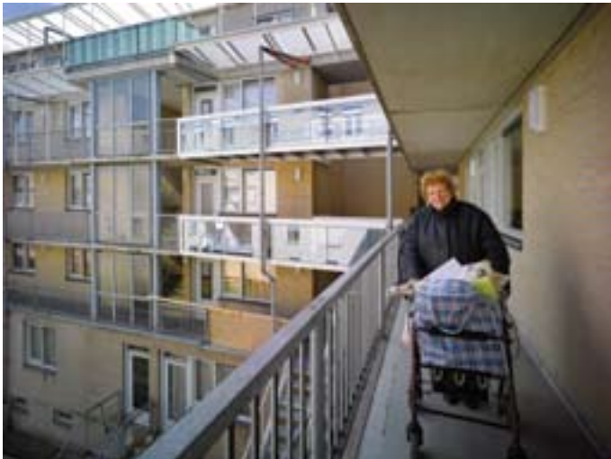
De verbindingsbrug aan de achterzijde van de Von Zesenstraat.
